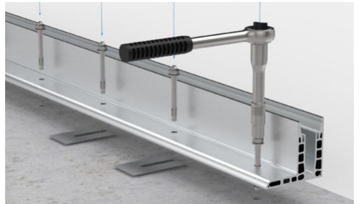
1. Profil anschrauben | mount the profile
