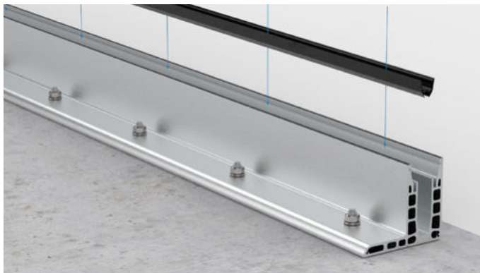
2. Unteres Verglasungsprofil einsetzen (im Außenbereich an den bauseitig hinzugefügten Entwässerungsbohrungen aussparen)
